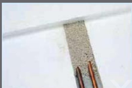
3. Спроведените цевки и водови се посипуваат со сув насип до висина на изолацијата.
