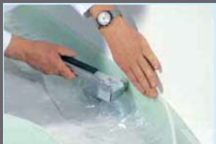
1. На околните сидови се прицврстува дилатациона лента со фолија.
