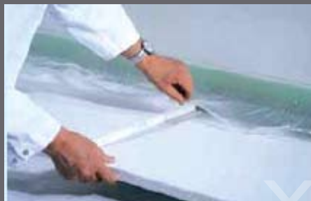
2. Се поставува изолациониот материјал по целата површина на подот.
