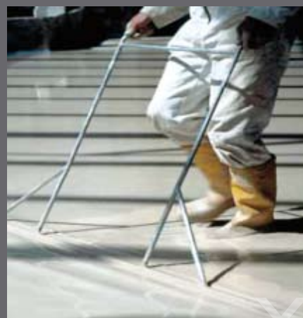
8. Се отстрануваат нивелетите и со вибрационата летва или четка за естрих се врши завршна обработка на површината.
